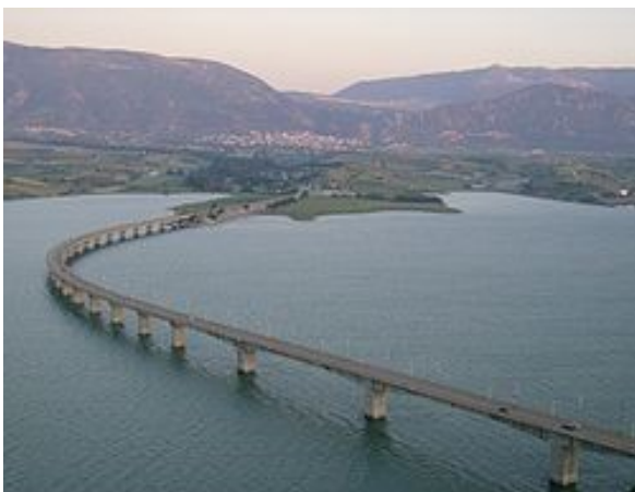
Εικόνα 5. Η γέφυρα Πολυφύτου στον Αλιάκμονα.
