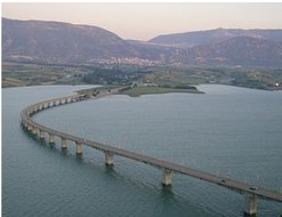
Εικόνα 5. Η γέφυρα Πολυφύτου στον Αλιάκμονα.
