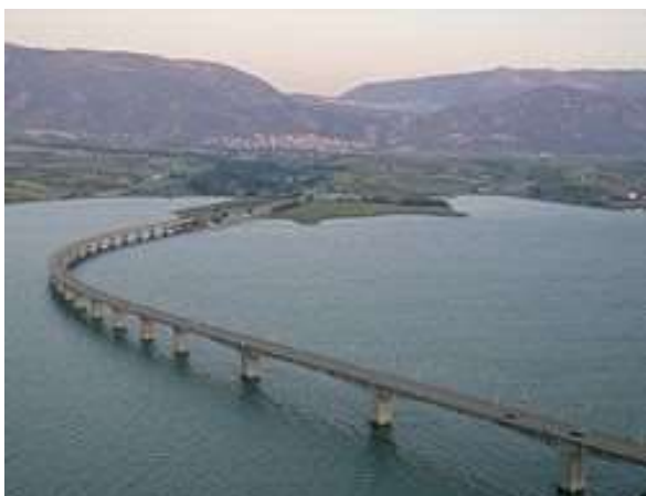
Εικόνα 5. Η γέφυρα Πολυφύτου στον Αλιάκμονα.
