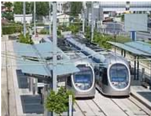
Εικόνα 13: Συρμός του Τραμ στο Σταθμό Image 13: Tram train in Irinis and Filias Stadium Station
